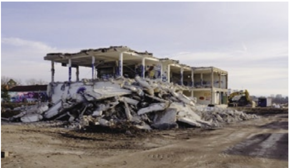
Abbrissarbeiten im Norden des C-Areal kommen im Februar 2023 vorläufig zum Ende
